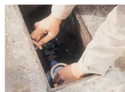
水道メーターの交換に。
