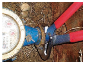
配管作業・電設作業に。
