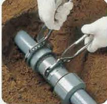
サイズの大きい継手 (MCユニオン、LAジョイント) に...
