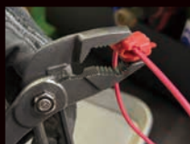
エレクトロタップ配線の修理
